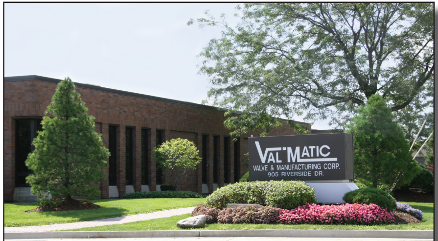
Elmhurst, IL Facility
