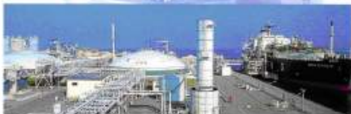
LNG receiving terminal
