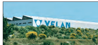
Lisbon, Portugal Velan Válvulas Industriais, Lda.
