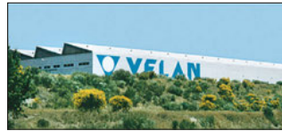
Lisbon, Portugal Velan Válvulas Industriais, Lda.
