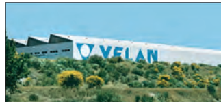
Lisbon, Portugal Velan Válvulas Industriais, Lda.
